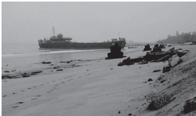
圖 4 海軍登陸艇運補繫攬樁因海砂流失造成繫攬樁底部外露及路燈底座崩塌圖
