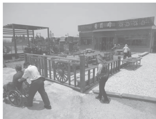
(f) 星月灣民宿餐廳路面以海沙及石頭鋪地造景，輪椅通行不便
